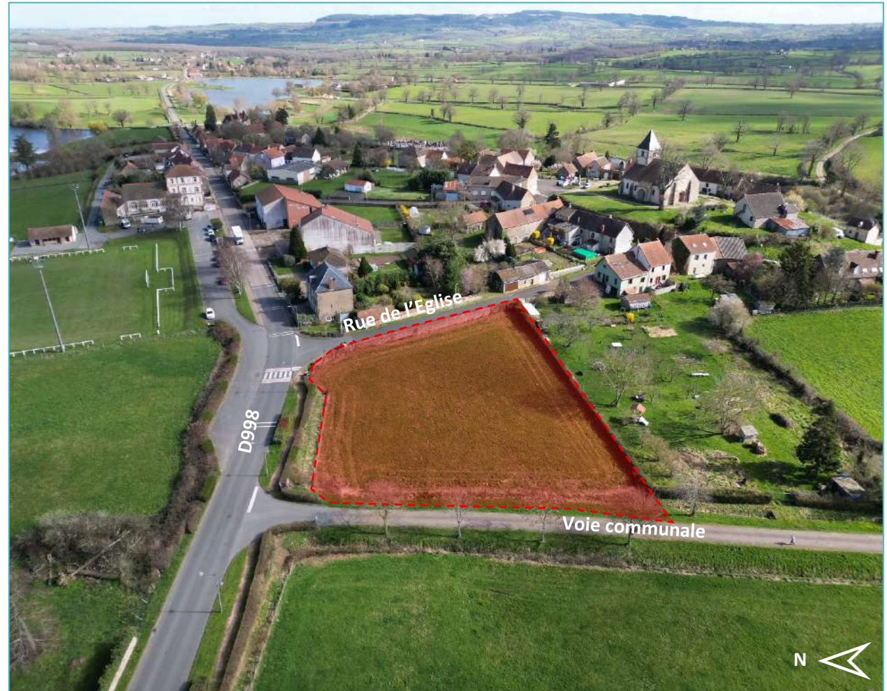
Vue aérienne du secteur "Le bourg" - ©Campus Développement
