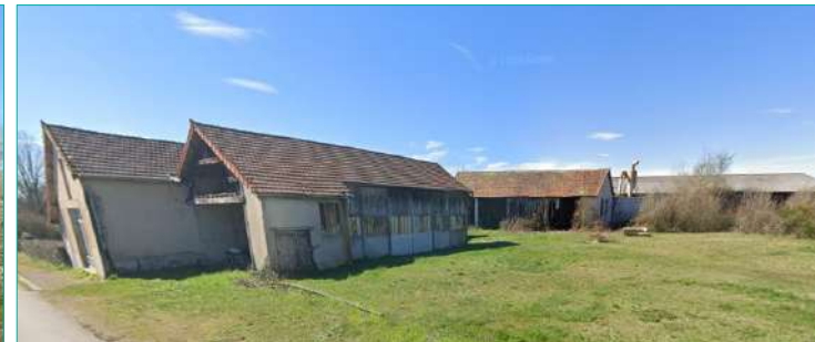
Bâtiments sur la parcelle YE 113 - ©Google Street View
