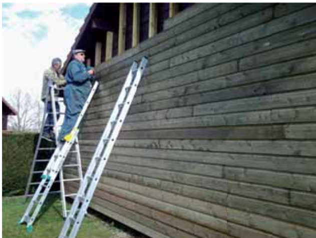
Rénovation des chalets
